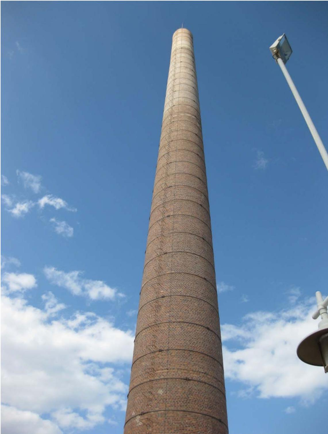
*9. Ilustración: Aquí se aprecia el pararrayos que se colocó en la restauración y la línea que lo une a tierra.*
