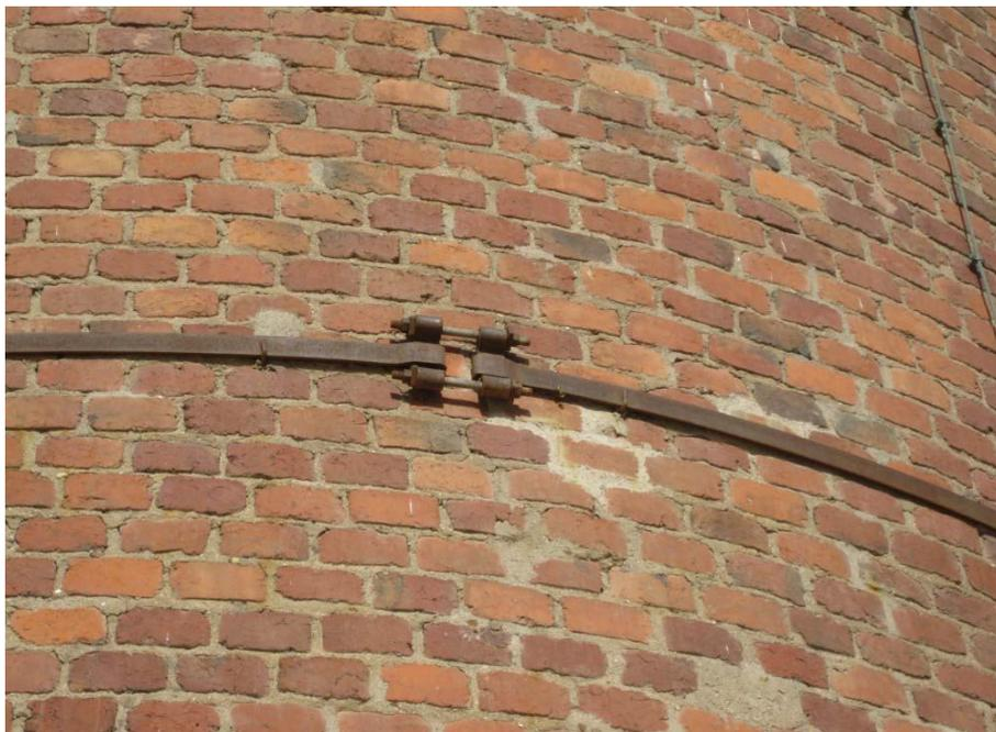
3. Ilustración: Para mantener los ladrillos unidos frente a las dilataciones que produciría el calor se le añadió unos cinturones de acero. Aquí un detalle del cierre.
