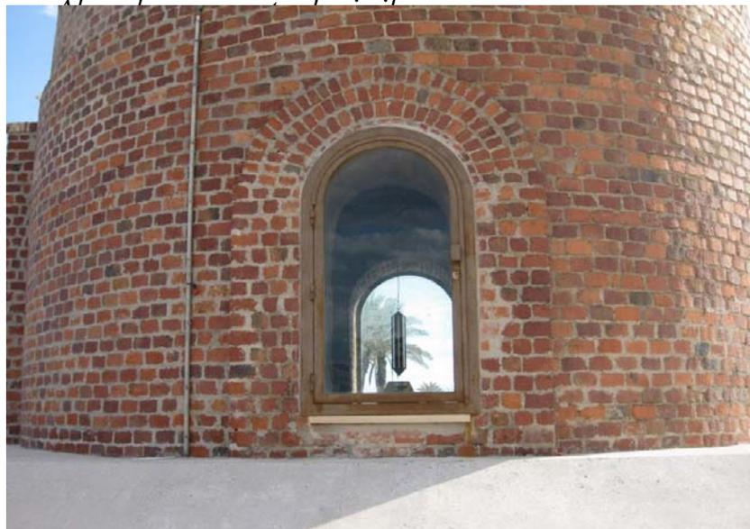
8. Ilustración: Entrada este de la chimenea, al oeste hay una gemela. El tubo metálico es la línea alimenta un foco.
