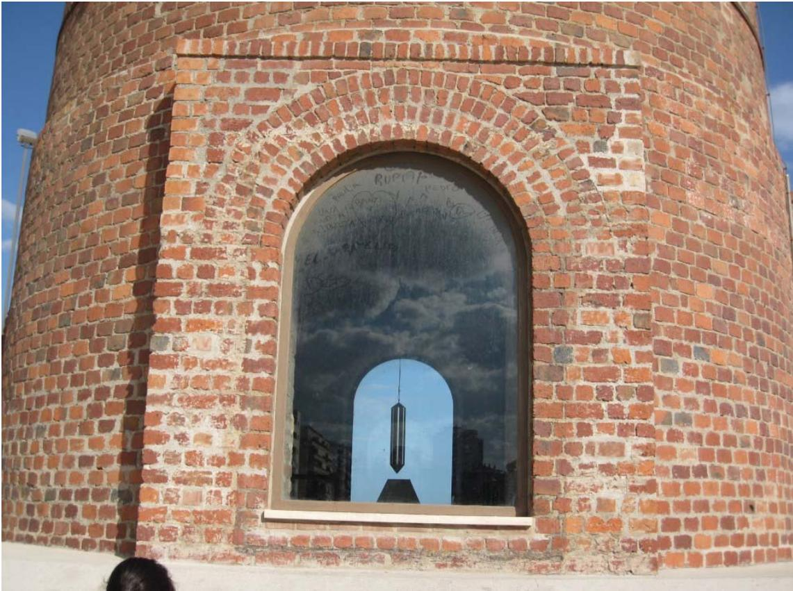
7. Ilustración: Vista general de la entrada oeste de la chimenea, lo que se ve es un péndulo que se colgó durante la restauración de la cúspide de la chimenea para visualizar movimientos sísmicos y posibles oscilaciones de la torre. Además se añadió un tubo metálico para alimentar un foco.
