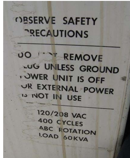
5. Ilustración: Observe que la tensión es de 120 V y la frecuencia de 400 Hz. Esto último muy diferente a los 50/60 Hz de las redes terrestres.
